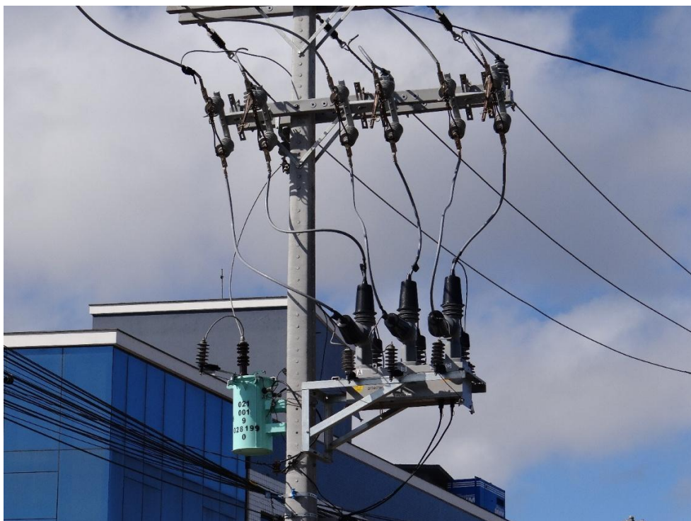
Fotografia 29: Instalação de religadores telecomandados em Santa Antônio da Patrulha (2)
