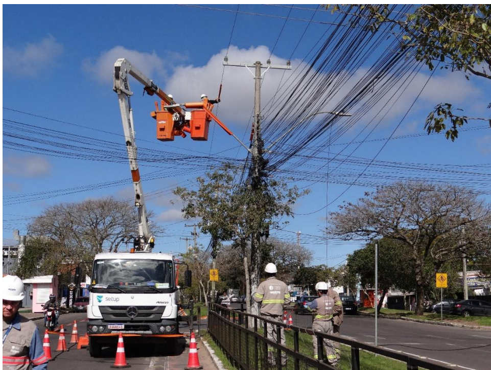
Fotografia 27: Manutenção sendo realizada por equipe de linha viva, no bairro Restinga
