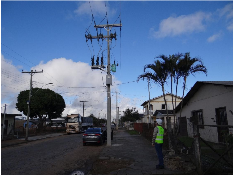
Fotografia 29: Instalação de religadores telecomandados em Santa Antônio da Patrulha (2)
