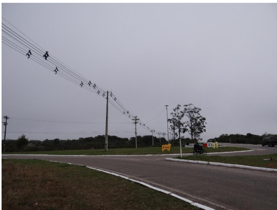
Fotografia 7: Novo trecho de 40 Km em rede compacta no alimentador UPME-5
