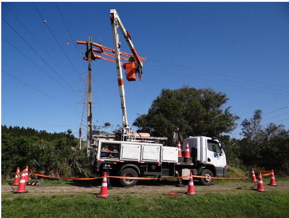
Fotografia 33: Manutenção em linha viva sendo realizada em Atlântida Sul
