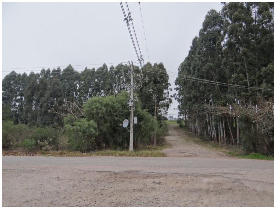
Fotografia 9: Revitalização da rede do alimentador UPME-3 (1)
