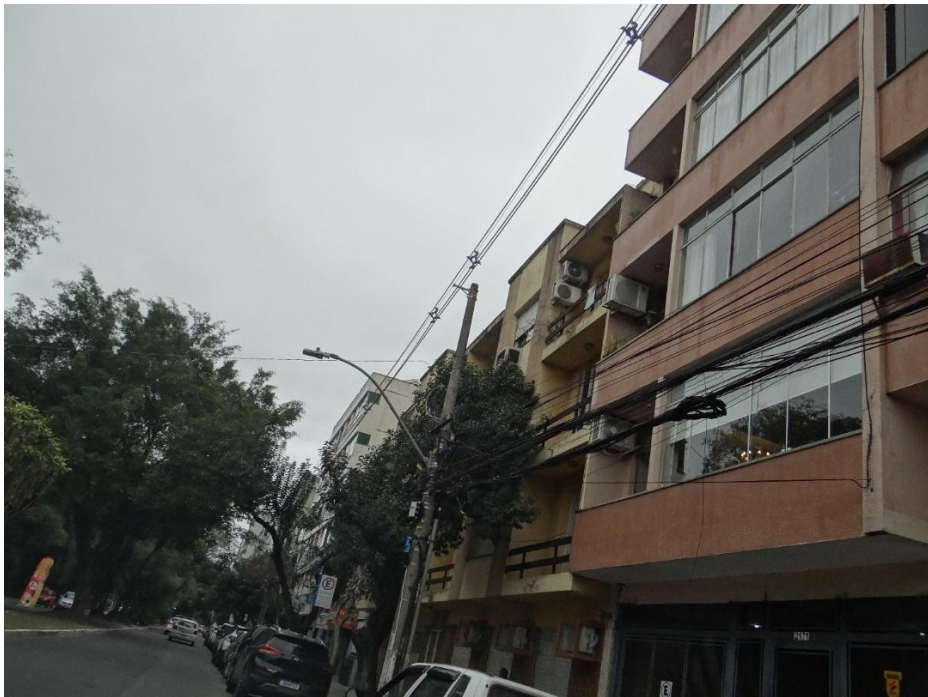
Fotografia 25: Recondutoramento da rede de distribuição na Rua Ramiro Barcelos
