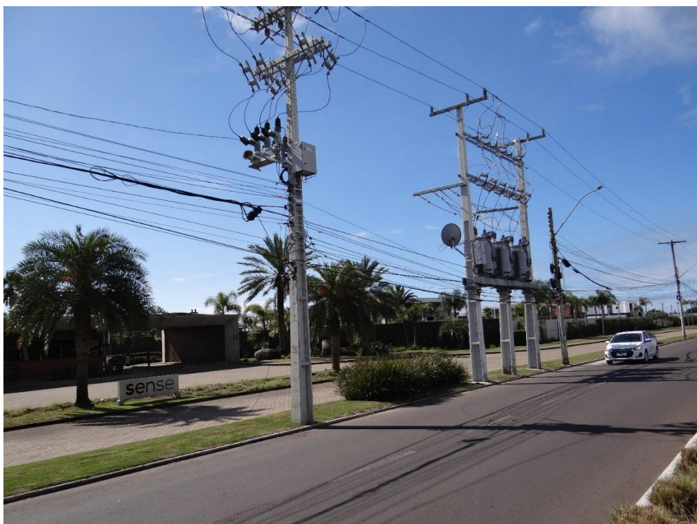
Fotografia 31: Novos equipamentos (inclusive regulador de tensão) no município de Xangri-lá
