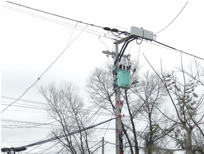
Fotografia 21: Instalação de sistema SMC nos bairros Humaitá e Restinga
