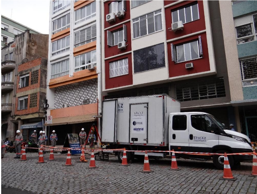
Fotografia 22: Substituição de trechos da rede subterrânea no centro de Porto Alegre
