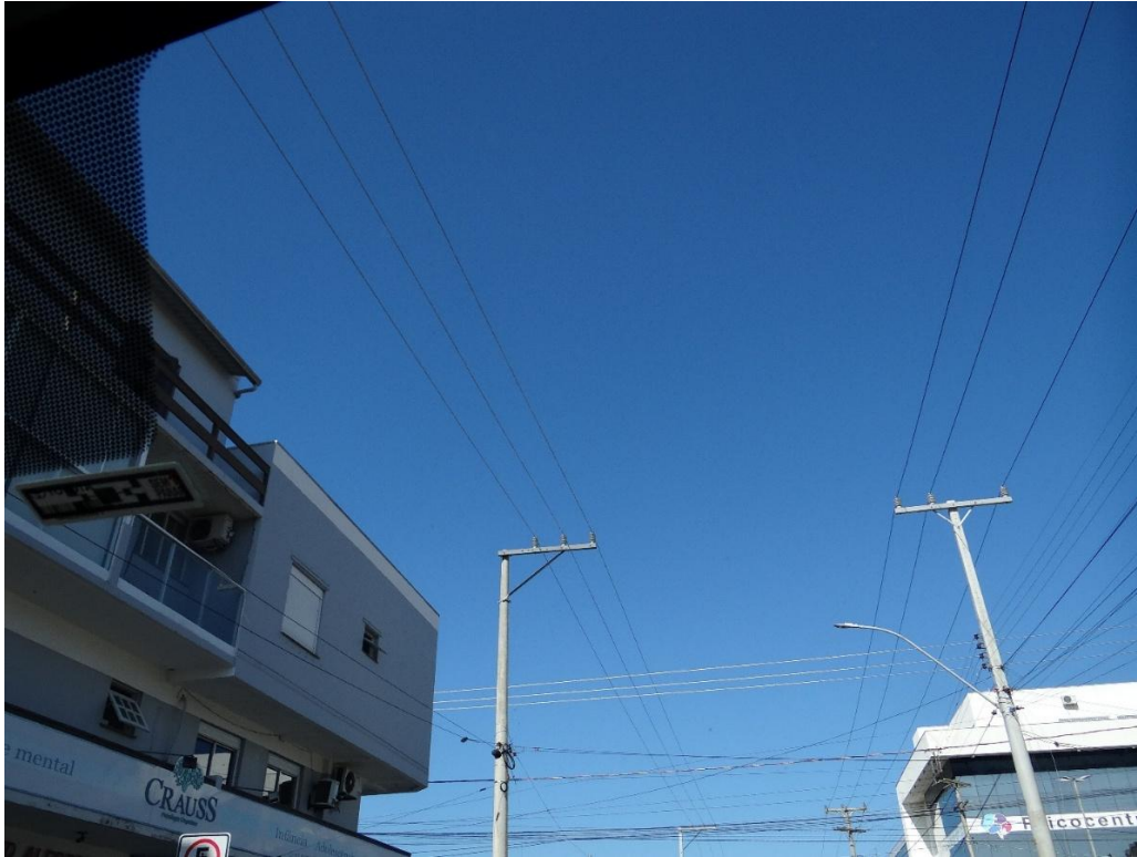
Fotografia 32: Novas redes dos alimentadores TRA-1 e TRA-2
