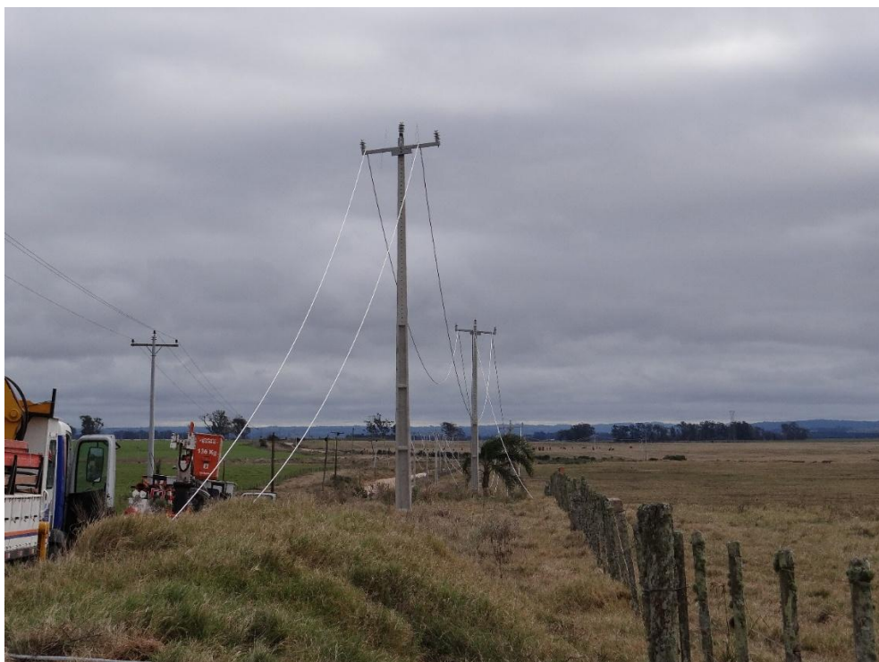
Fotografia 17: Construção de novo circuito para o alimentador POS-3.
