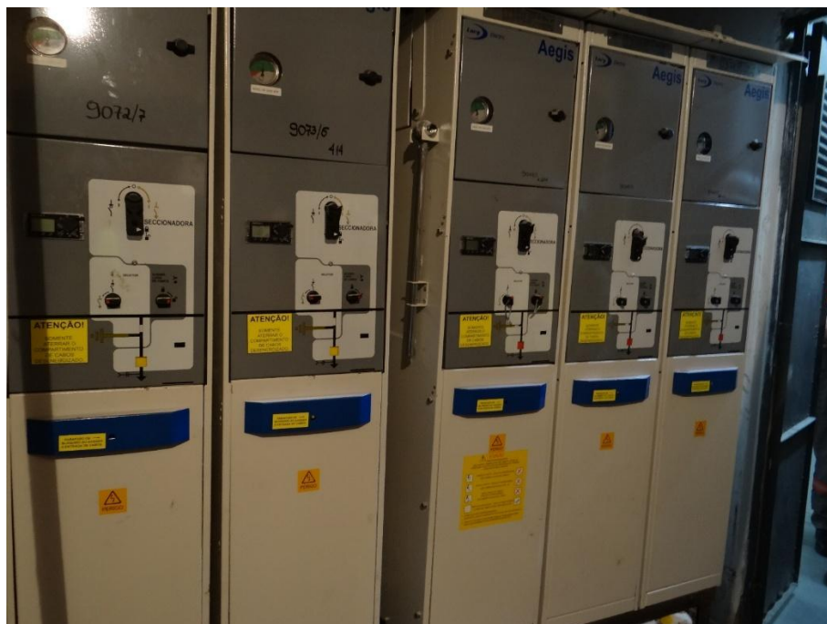
Fotografia 23: Implantação de chaves a gás na rede subterrânea de Porto Alegre
