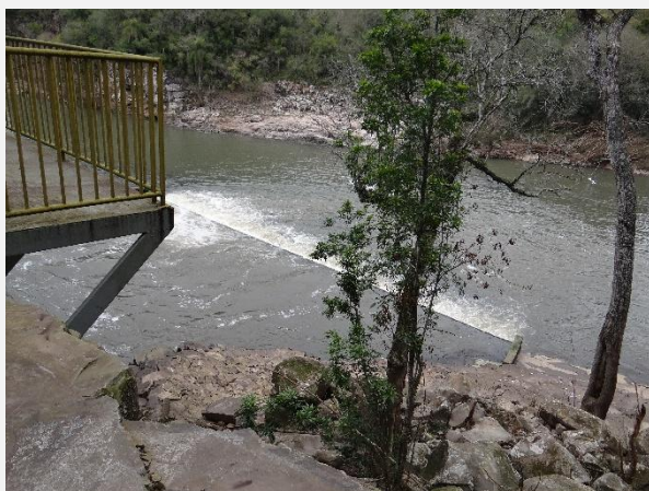
Canal de fuga da PCH Quebra Dentes.
