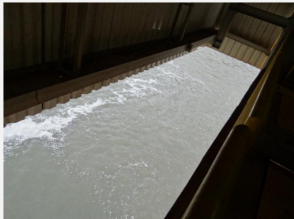
Canal de Fuga da Casa de Máquinas da PCH Rincão São Miguel.
