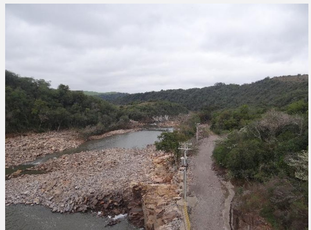
Jusante da Barragem da PCH Quebra Dentes.
