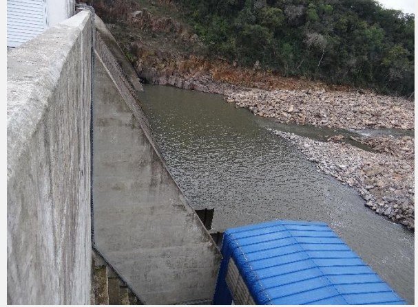
Jusante da Barragem da PCH Quebra Dentes.
