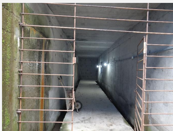
Galeria de Drenagem da Barragem da PCH Cachoeira Cinco Veados.
