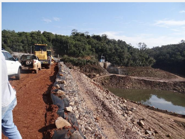
Alteamento do barramento da margem esquerda da PCH Salto do Guassupi.
