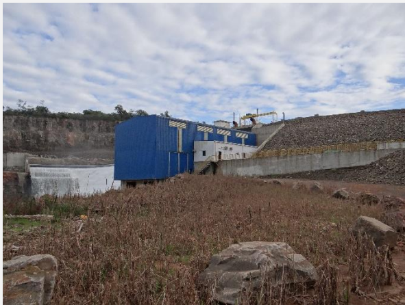
Casa de Máquinas junto à margem esquerda da barragem da PCH Rincão São Miguel.
