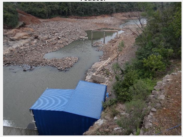
Vista de Jusante da Barragem da Cachoeira Cinco Veados.
