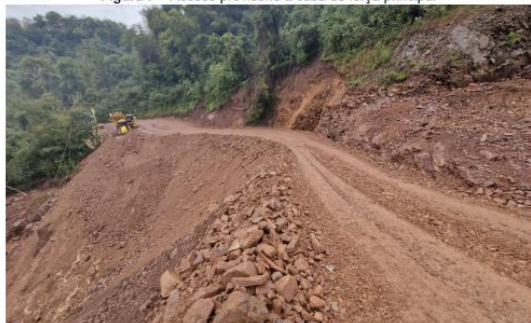
Figura 7 – Acesso provisório à casa de força principal
