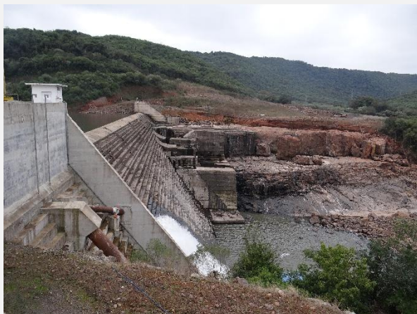
Jusante da Barragem da Cachoeira Cinco Veados.
