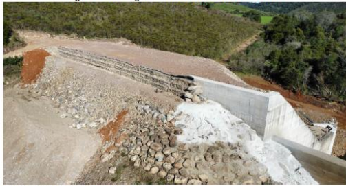
Figura 4 – Barragem de enrocamento vista montante
