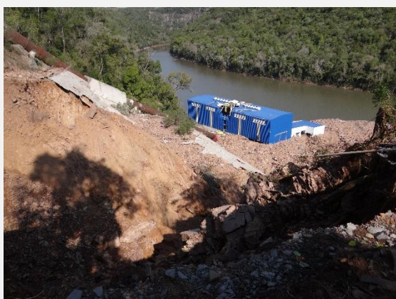
Casa de força da PCH Salto do Guassupi avariada pelo deslocamento de água e terra no evento de junho de 2025.
