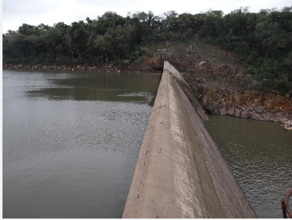
Barragem da PCH Quebra Dentes.
