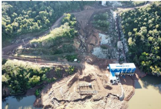
Figura 8 – Início da recuperação do pátio e da subestação
