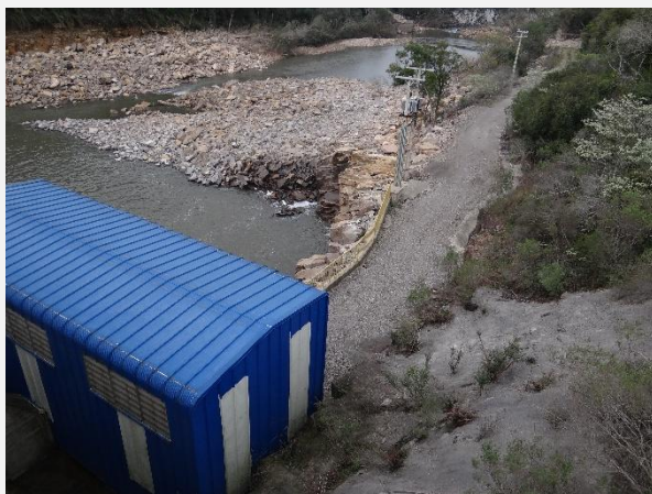
Casa de força secundária da PCH Quebra Dentes.
