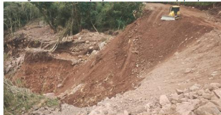
Figura 13 – Início da recuperação do talude na casa de força principal
