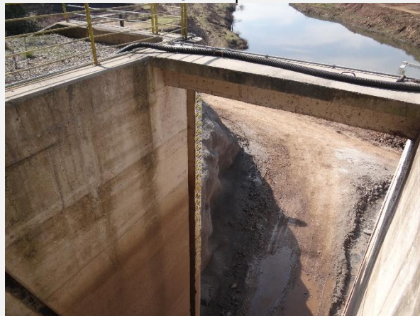
Tomada d'água e túnel de adução da PCH Salto do Guassupi.
