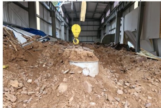
Figura 10 – Início da recuperação da área interna da casa de força
