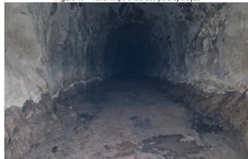
Figura 15 – Túnel limpo e liberado para operação
