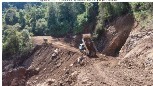
Figura 11 – Acesso a casa de força principal
