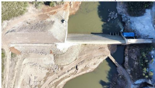
Figura 5 – Barragem de enrocamento vista superior
