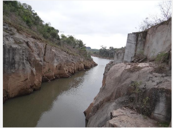
Canal de Adução da PCH Quebra Dentes.
