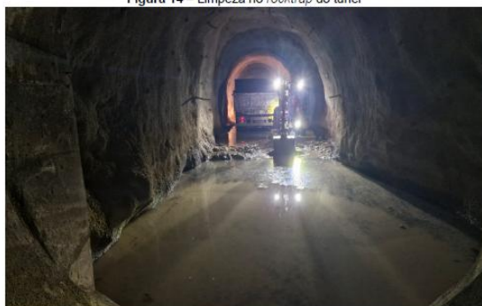
Figura 14 – Limpeza no rocktrap do túnel
