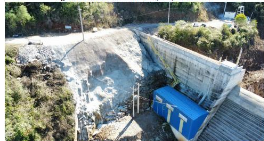
Figura 6 – Ombreira direita - recuperação concluída
