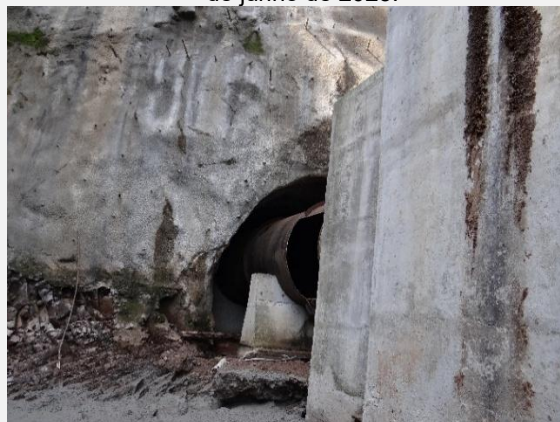
Abertura no conduto metálico para manutenção do túnel de adução junto à chaminé de equilíbrio da PCH Salto do Guassupi, por onde passou a água no evento de junho de 2025.
