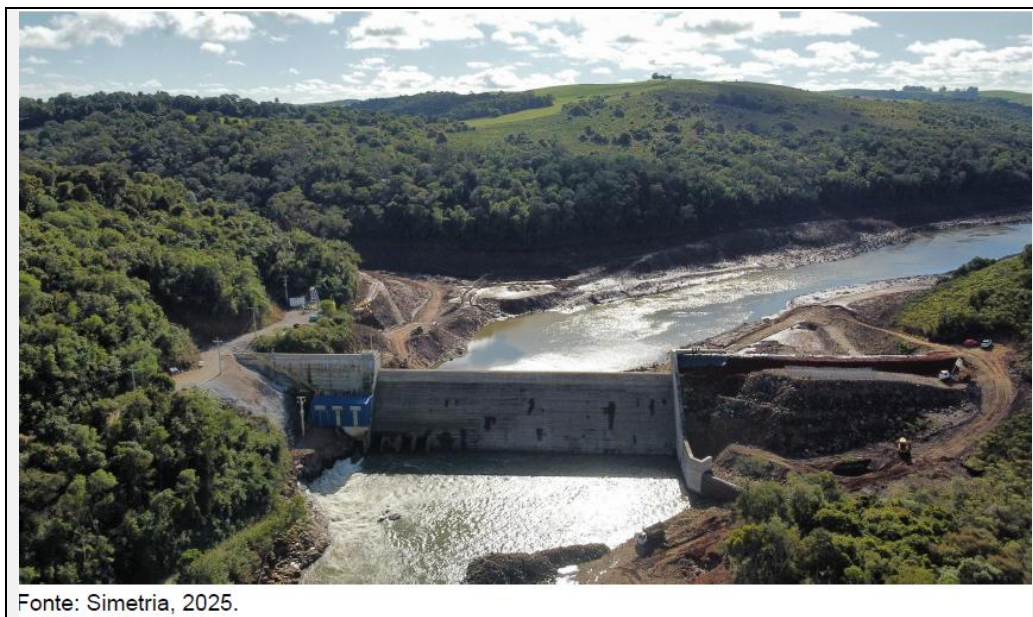
Figura 3 – Barramento da PCH Salto do Guassupi
