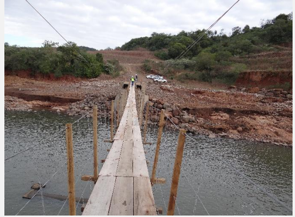
Acesso provisório à margem esquerda, para pedestres, na PCH Rincão São Miguel.
