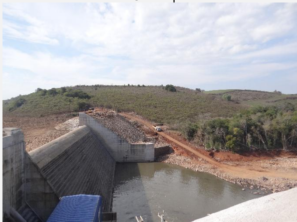
Vista da margem direita. Finalização da obra da barragem na margem esquerda jusante da PCH Salto do Guassupi.
