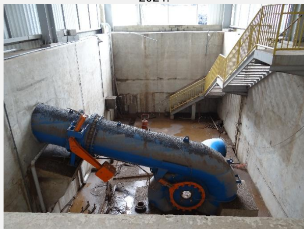
Casa de Máquinas Auxiliar da PCH Cachoeira Cinco Veados, avariada pelos efeitos do evento de maio de 2024.
