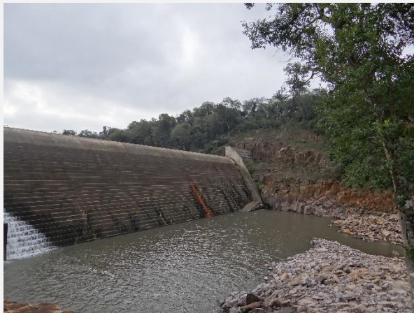
Jusante da Barragem da PCH Quebra Dentes.
