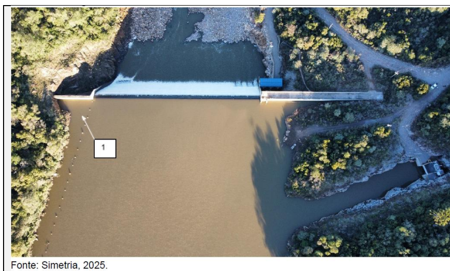
Figura 5 – Reservatório da PCH Quebra Dentes.
