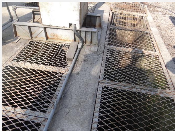
Comporta da tomada d'água da PCH Salto do Guassupi.
