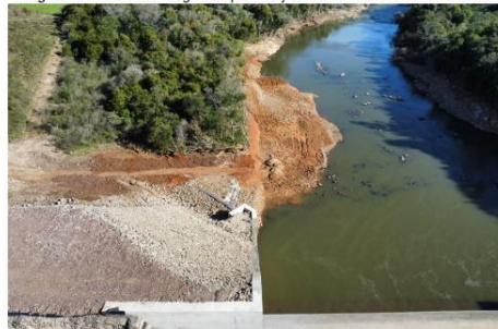
Figura 12 – Talude da margem esquerda a jusante do vertedouro - confirmado
