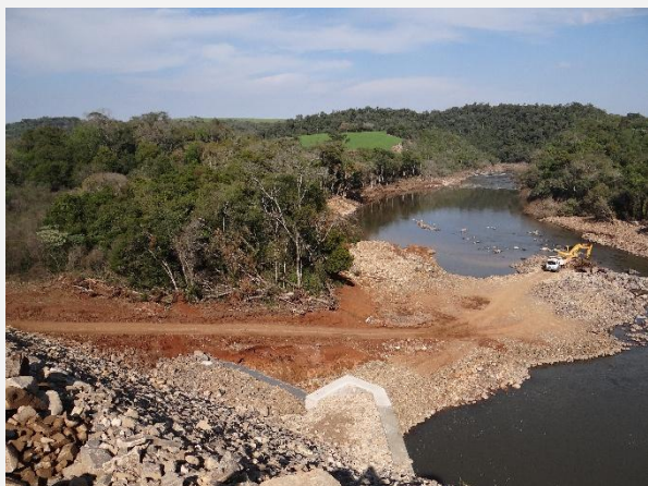
Vista para a jusante, obra da margem esquerda da barragem em finalização da PCH Salto do Guassupi.
