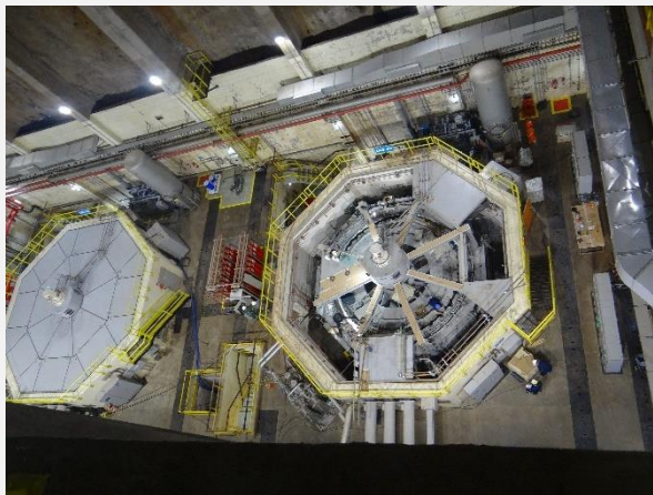
Melhorias no isolamento do estator da UG01 na casa de força da UHE Monte Claro.
