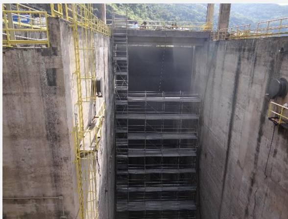
Recuperação da comporta do seguimento vertedouro com a instalação do stop-log e andaimes para instalação da nova comporta e retirada do stop-log.
