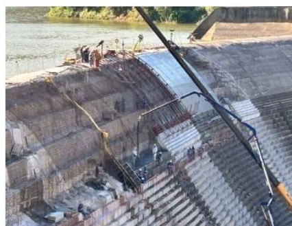
Figura 5 – Recuperação dos degraus danificados
