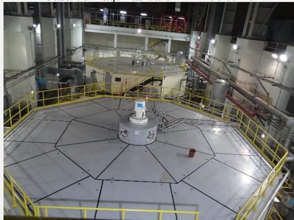
Casa de máquinas da UHE 14 de Julho.
