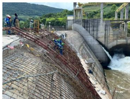
Figura 4 – Concretagem da soleira vertical
