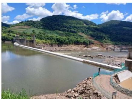
Figura 3 – Vista Geral do reservatório restabelecido – Jan/25
