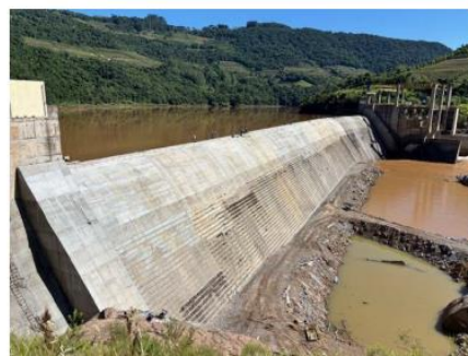
Figura 8 – Vista Geral da Barragem com Etapa 2 concluída – Mar/25
