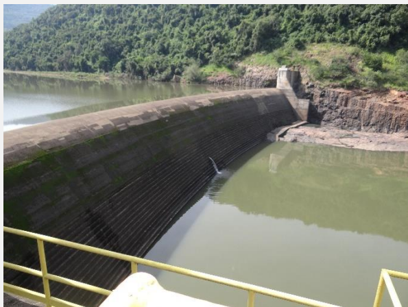
Barragem da UHE Monte Claro.
