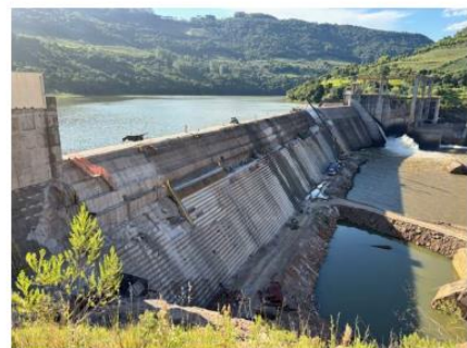
Figura 6 – Vista Geral da reconstrução dos degraus e concretagem da soleira vertical – Jan/25
