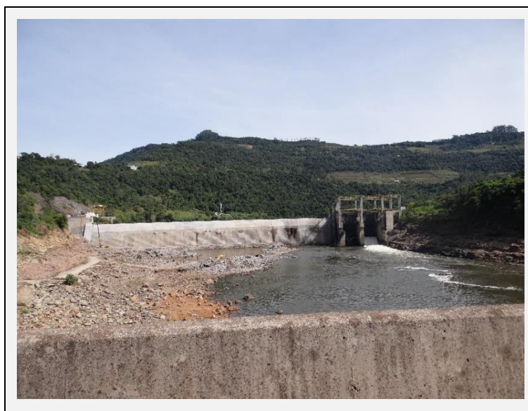
Figura 4 - Arranjo geral da UHE 14 de Julho.
