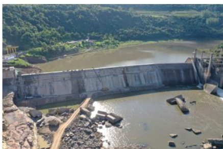
Figura 2 – Vista Geral da Barragem com Etapa 1 concluída (Blocos 7 a 16) – Jan/25
