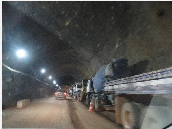
Desmobilização do canteiro de obras na UHE 14 de Julho.
