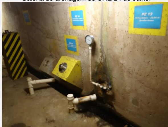
Galeria de drenagem de UHE 14 de Julho.
