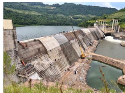
Figura 7 – Vista Geral da reconstrução dos degraus e concretagem da soleira vertical – Feb/25
