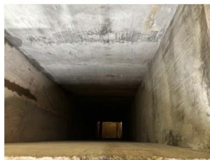
Figura 9 – Concretagem no poço do bloco 17 concluída
