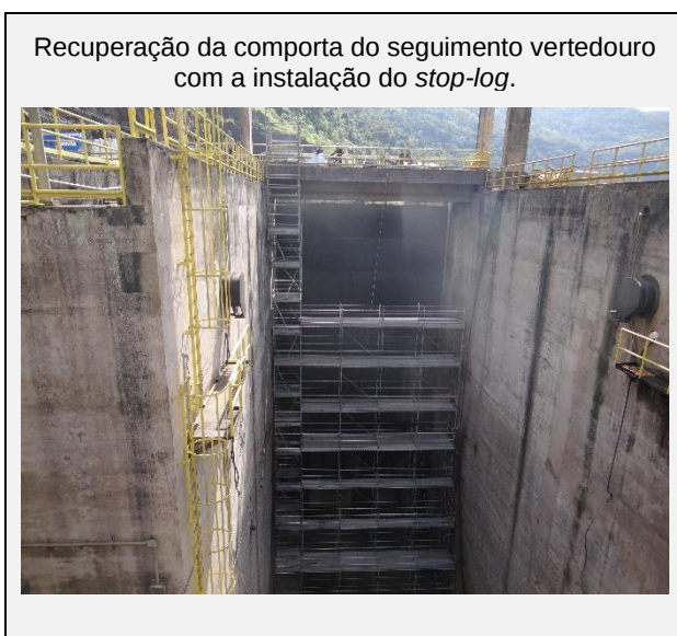
Figura 12 - Registro fotográfico das ações em andamento referentes a manutenção da comporta do seguimento vertedouro na UHE Monte Claro.
