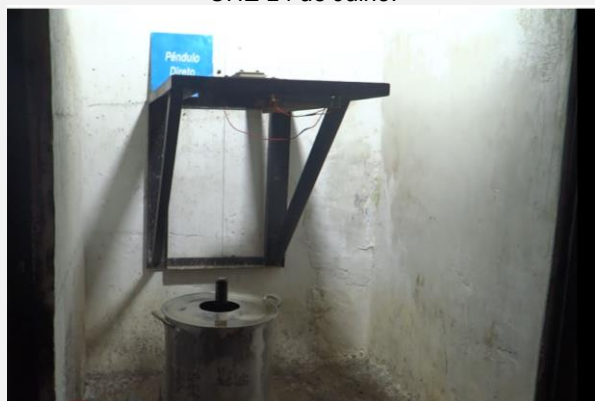
Instrumentação recuperada na galeria de drenagem de UHE 14 de Julho.
