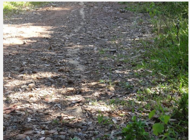
Preenchimento com concreto das fissuras que surgiram no talude da margem esquerda da barragem do Salto.
