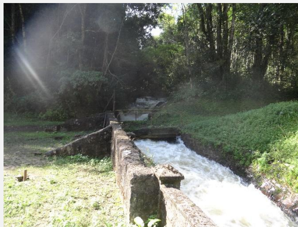
Canal de desvio da UHE Bugres.
