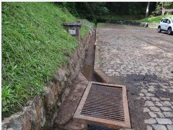
Bueiros junto a casa de força da UHE Bugres desentupidos.
