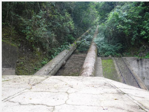
Conduto forçado da UHE Canastra.
