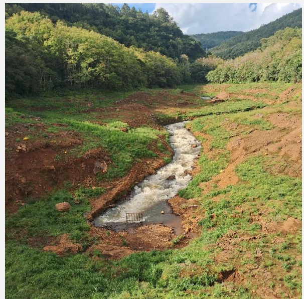
Descarga de fundo da barragem Canastra.
