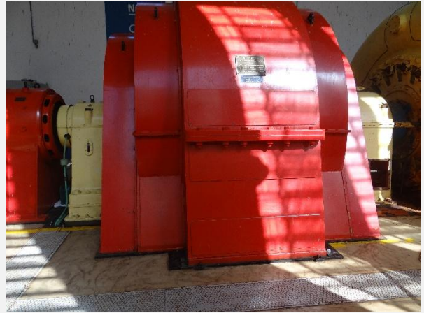
Casa de força na UHE Bugres.
