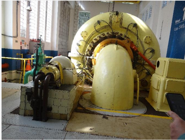
Casa de força na UHE Bugres.
