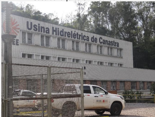
Casa de força da UHE Canastra.
