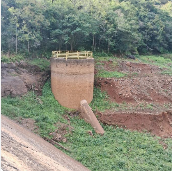
Vertedouro afunilado tipo tulipa da barragem Canastra.
