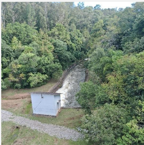
Vazão remanescente da barragem Canastra.
