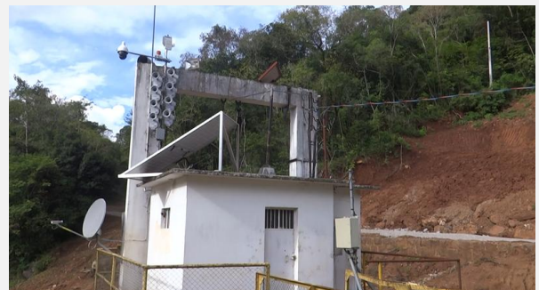
Sistema sonoro de alerta da barragem Canastra.
