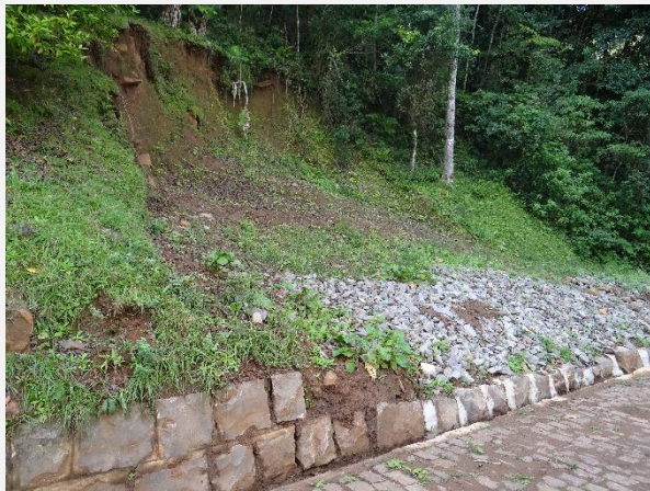
Talude junto a casa de força da UHE Bugres recuperado.
