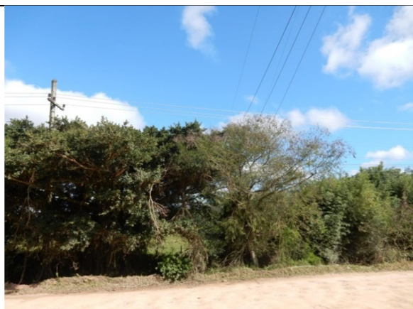
Foto 17 – SE Pelotas 3 – saída dos alimentadores.
