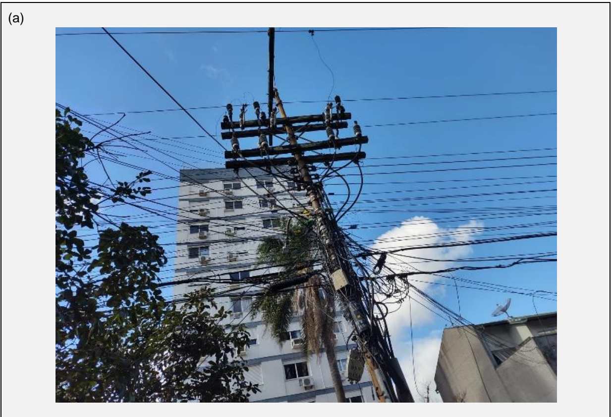
Figura 2 – Fotos do compartilhamento da infraestrutura da CEEE-D Equatorial na município de Porto Alegre, Rua Fernandes Vieira.
