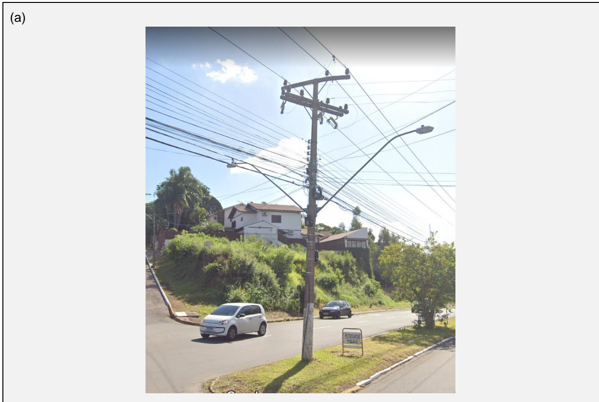
Figura 2 – Fotos do compartilhamento da infraestrutura da RGE no município de Novo Hamburgo, na Rua Ver. Adão Rodrigues de Oliveira.
