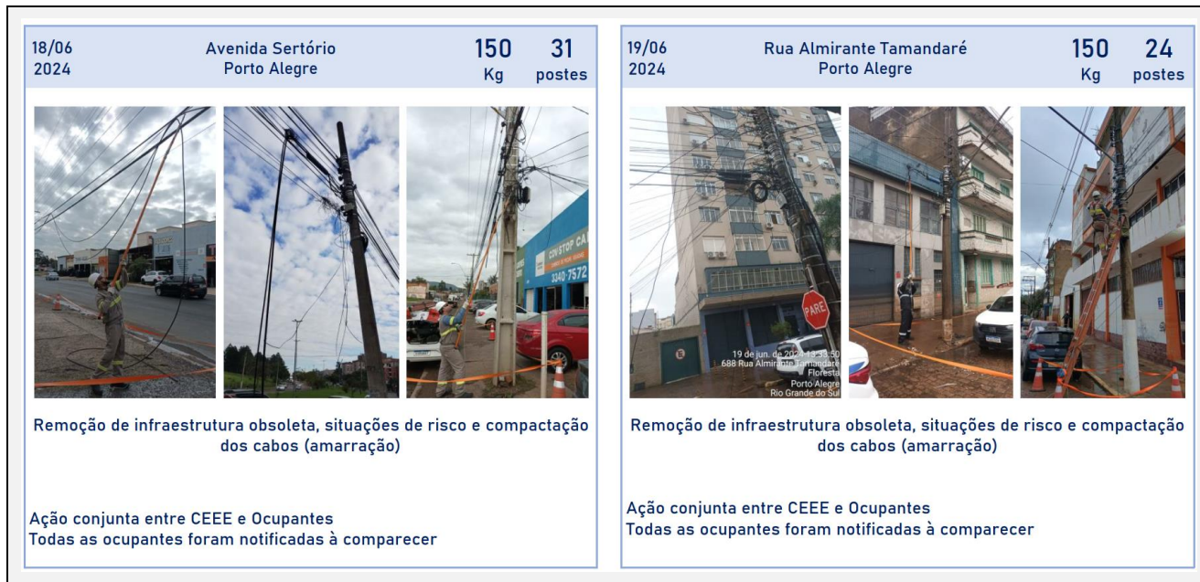
Figura 14 (cont.) - Registros fotográficos de ações de remoção de infraestrutura obsoleta, situações de risco e compactação dos cabos (amarração).
