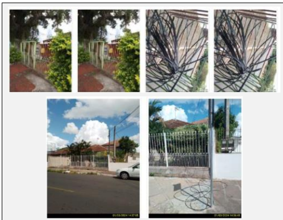
Figura 2 - Remoção de situações de risco no município de Canoas/RS.
